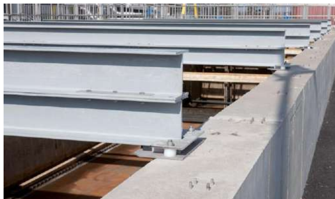
Structures support pour les couvertures.
