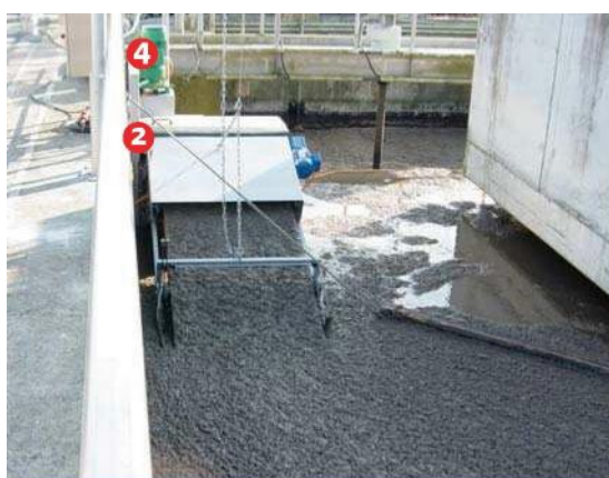
Écumeur de surface FS - version montée sur support.
